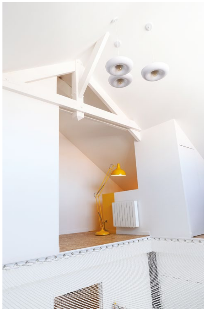
Charpente. Si la plupart des fermes installées lors de la réfection de la charpente étaient traditionnelles, les fermes à entrants retroussés segmentant l'étage facilitent le passage et l'occupation.
