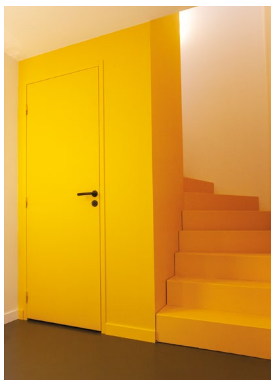
Entre le vestibule et le couloir noir, l'escalier en tôle pliée thermolaquée jaune mène à l'étage.
