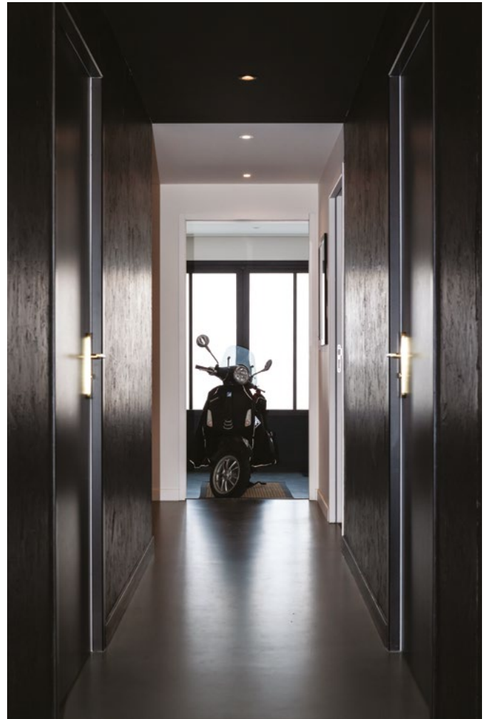
Le couloir resserre l'espace. Au fond, le vestibule, puis l'accès à l'étage par l'escalier, avant d'atteindre le couloir tout de noir paré. De part et d'autre les chambres du rez-de-chaussée. Cloisons en OSB teinté en noir. Sol en résine.
