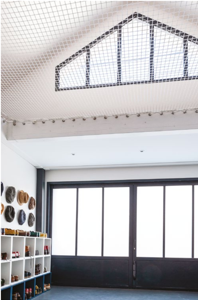
Le vestibule spectaculaire. Le portail en aluminium avec vitrage securit en verre dépoli est coulissant et à galandage. Il donne sur un vestibule aux dimensions spectaculaires. Au-dessus une trémie dans le plancher de l'étage a permis l'installation d'un filet d'habitation par lequel passe la lumière naturelle de l'ouverture trapézoïdale créée dans la façade d'origine.
