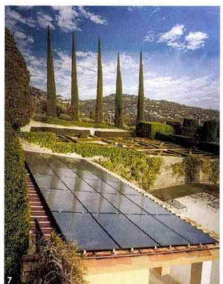
**7. Panneau 2 en 1 SPRING** DualSun a conçu le premier panneau solaire hybride certifié au monde: le panneau 2 en 1 SPRING. Il produit à la fois de l'électricité et de l'eau chaude et permet d'obtenir trois fois plus d'énergie par m<sup>2</sup> de toiture qu'un panneau photovoltaïque standard. Il convient à tous types de bâtiments. Prix sur demande. [www.dualsun.com](http://www.dualsun.com)
